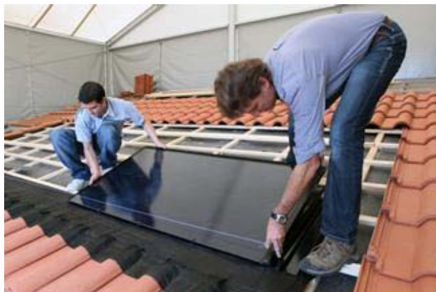
2 Module von unten nach oben und rechts nach links einlegen.
