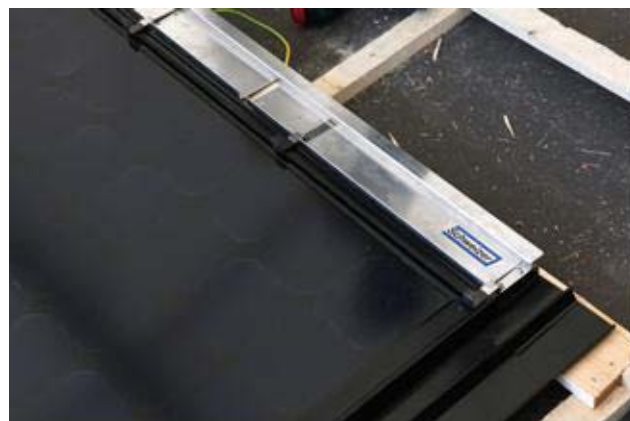
3 Nächste Bügelreihe mit Hilfe der Montagelehre anbringen.
