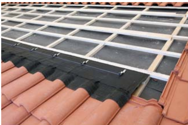
1 Unteren Anschluss und erste Bügelreihe vorbereiten.
